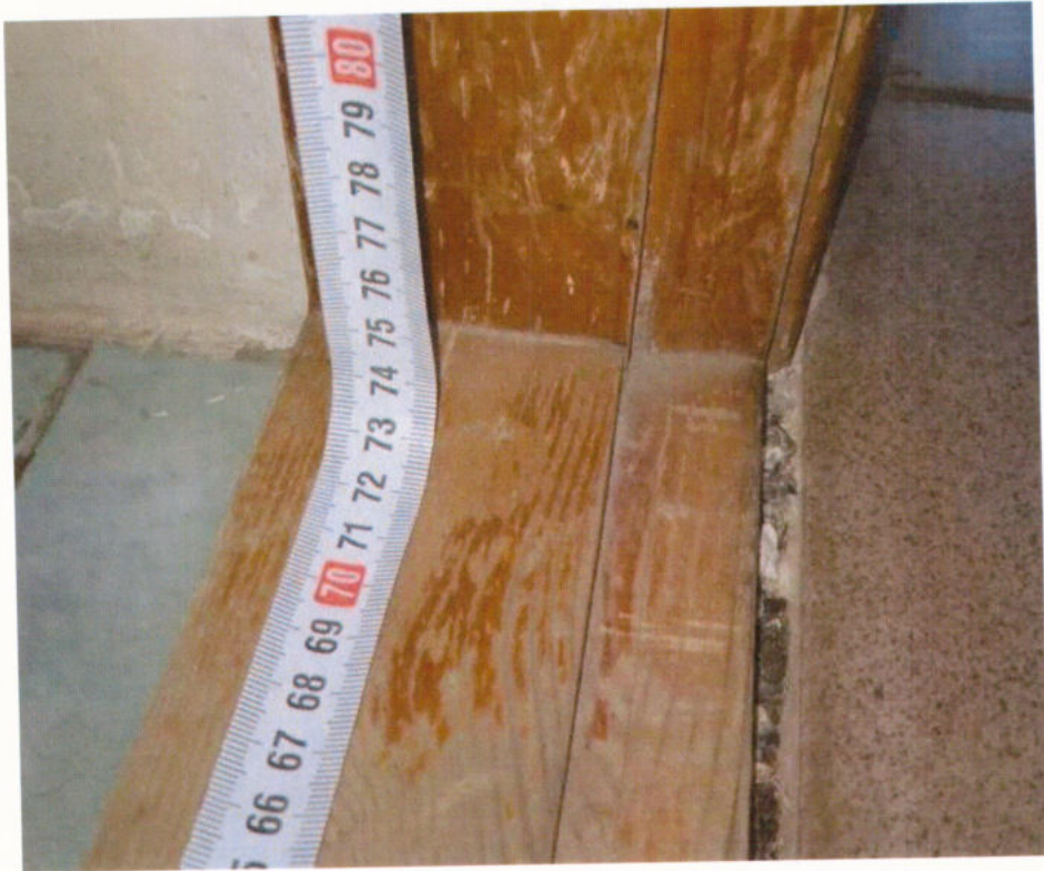
Ширина дверного проема 1 этаж
