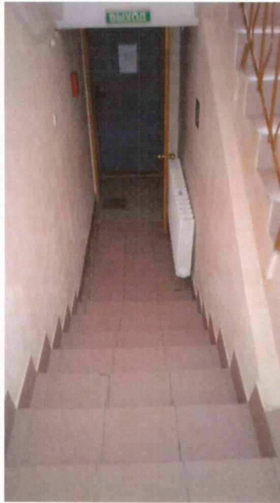
Вид лестничного марша эвакуационного пути (пример)
