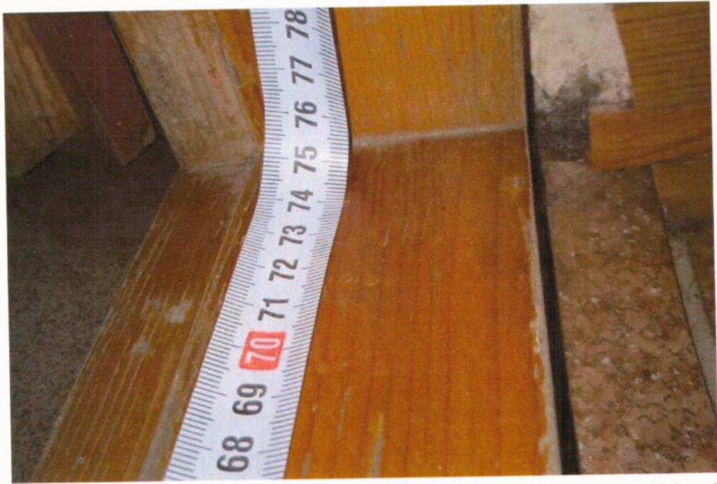
Высота порога в гардероб – не соответствует нормативу (14мм)
