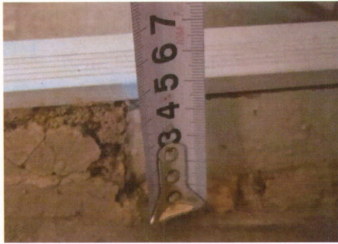
Высота порога в гардероб – не соответствует нормативу (14мм) Высота размещения вешалок
