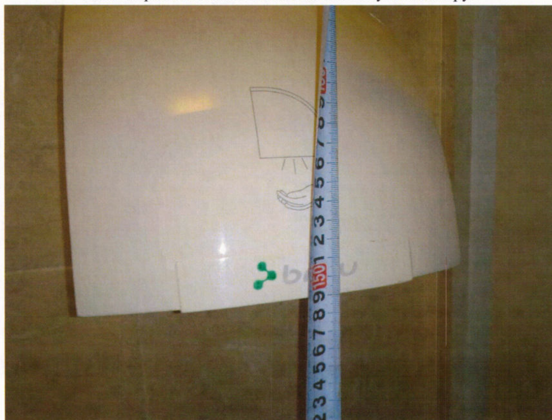
Высота размещения автоматической сушилки для рук
