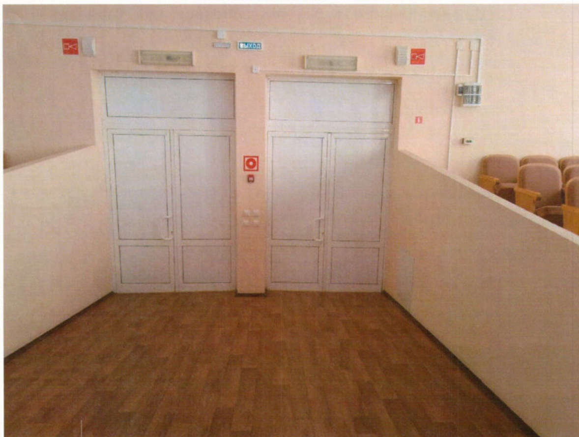
Малозаметное препятствие на пути эвакуации по ходу движения (имеются выбоины в полу, пороги) Выход из актового зала
