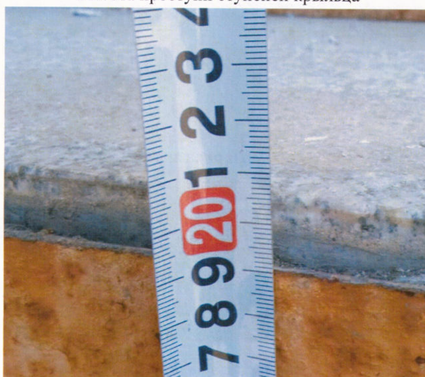
Высота проступи ступеней крыльца
