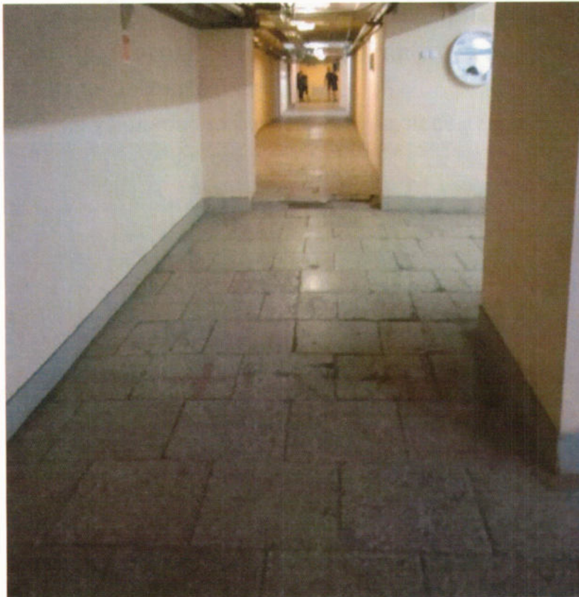
Малозаметное препятствие на пути эвакуации по ходу движения (имеются выбоины в полу, пороги) Выход из актового зала
