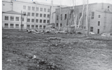
Строительство актового и спортивного залов в Кировском районе, 1957 год.
